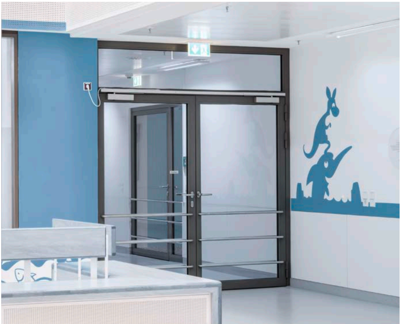
Gleitschientürschließer TS 5000 R-ISM, Olghospital Stuttgart, Deutschland (Foto: Jürgen Pollak / GEZE GmbH)
